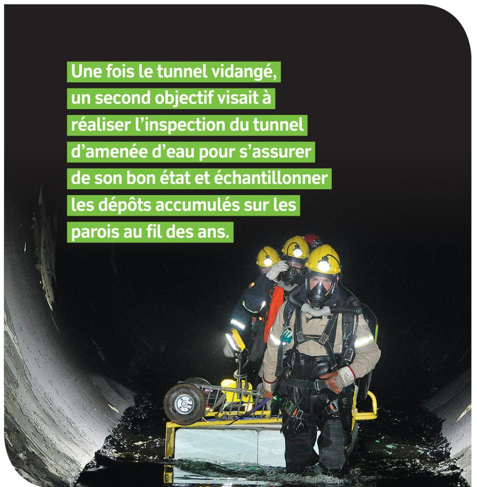
Une fois le tunnel vidangé, un second objectif visait à réaliser l'inspection du tunnel d'amenée d'eau pour s'assurer de son bon état et échantillonner les dépôts accumulés sur les parois au fil des ans.
