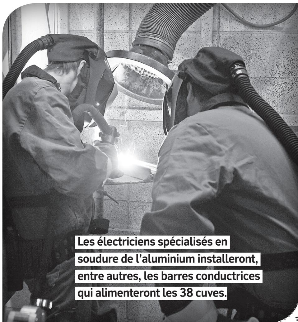
**Les électriciens spécialisés en soudure de l'aluminium installeront, entre autres, les barres conductrices qui alimenteront les 38 cuves.**
